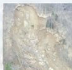
Frana di Pian dei Sisi
