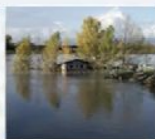
Rottura argine dei Renai
