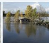
Rottura argine dei Renai
