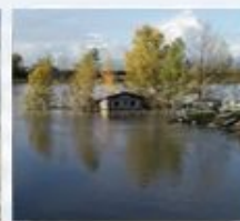
Rottura argine dei Renai
