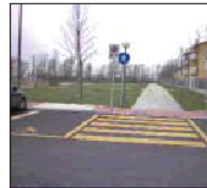
A1-3 Parcheggio riservato - raccordo al percorso pedonale Esempio di integrazione tra percorso pedonale e segnaletica orizzontale
