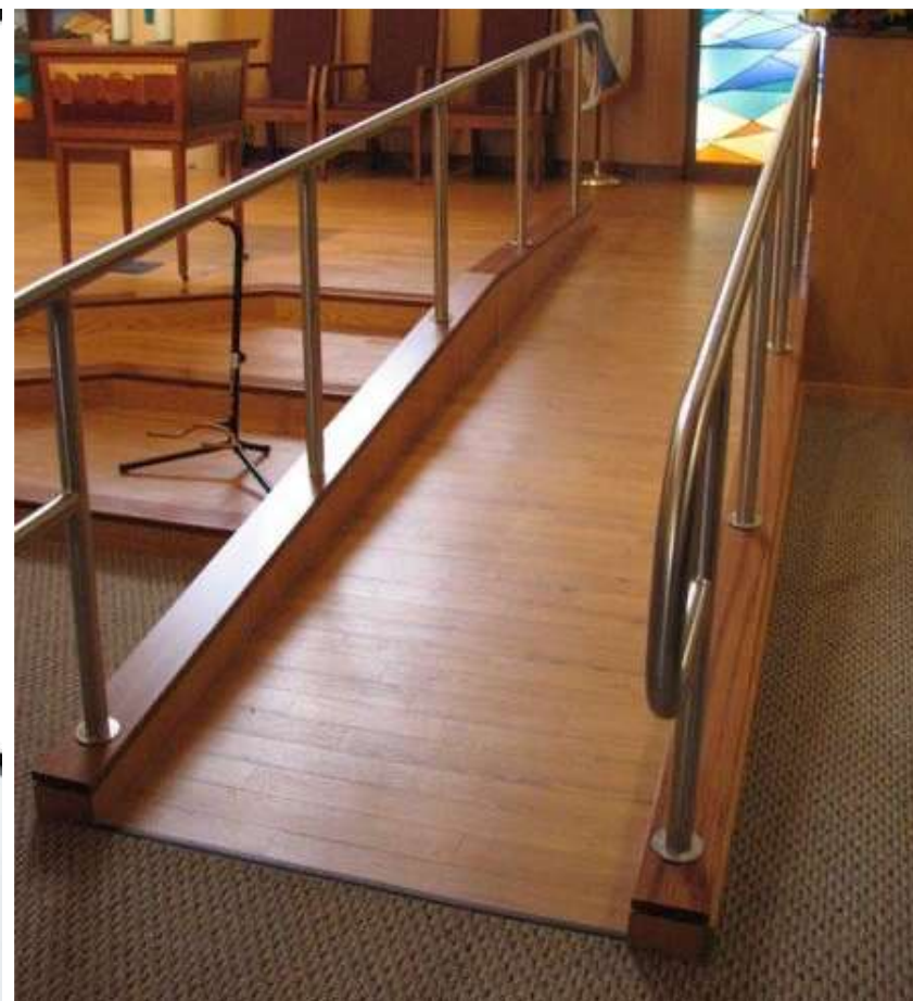
Rampa con fermaruota e corrimano
