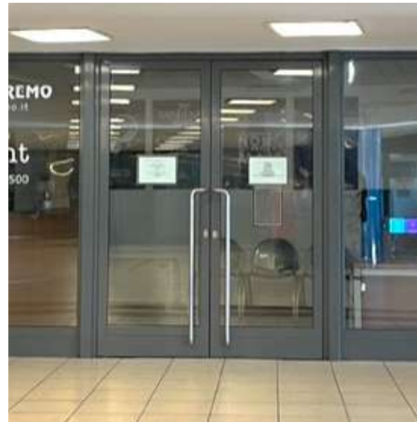
Porta a battente 2 sensi di apertura e maniglia con flessibilità di altezza
